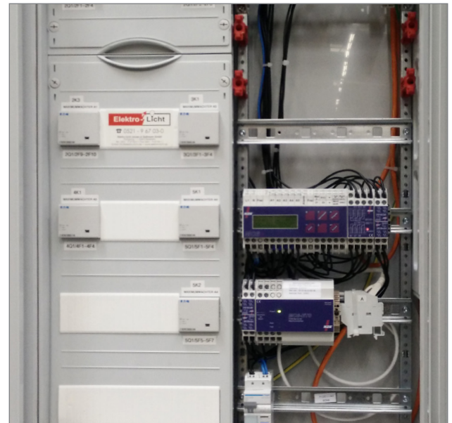
NZR Technik im Einsatz: der Maximumwächter MC6+ verhindert durch ständige Kontrolle des Energieverbrauches die zufallsbedingte Gleichzeitigkeit elektrischer Verbraucher und spart durch rechtzeitige Regemaßnahmen.
