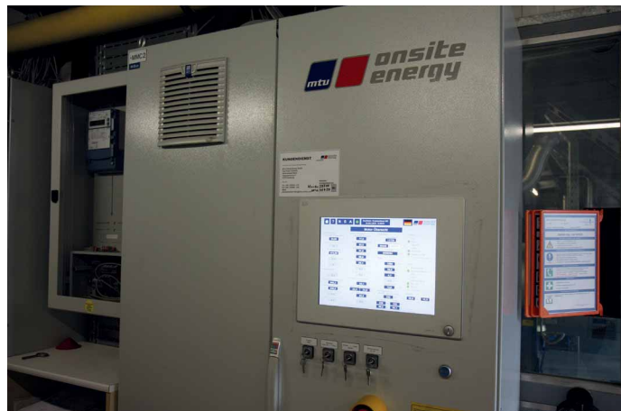
Das Blockheizkraftwerk ist komplett renoviert worden.
